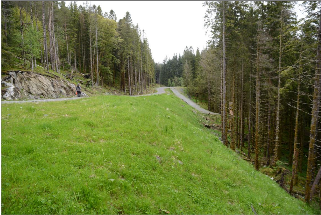
Figur 4. Skogsbilvei over Birkelandsfjellet i Fana i mai 2023. Personen til venstre i bildet viser hvor store fyllingene er i området (estimert høyde på fyllingsfot var her 15–20 meter). Det er nokså åpenbart at denne type veier er en effektiv måte å få dumpet store mengder masser på – med de svært negative følgene som det får både for natur- og friluftslivsverdiene. Foto: Gunvar Mikkelsen.
