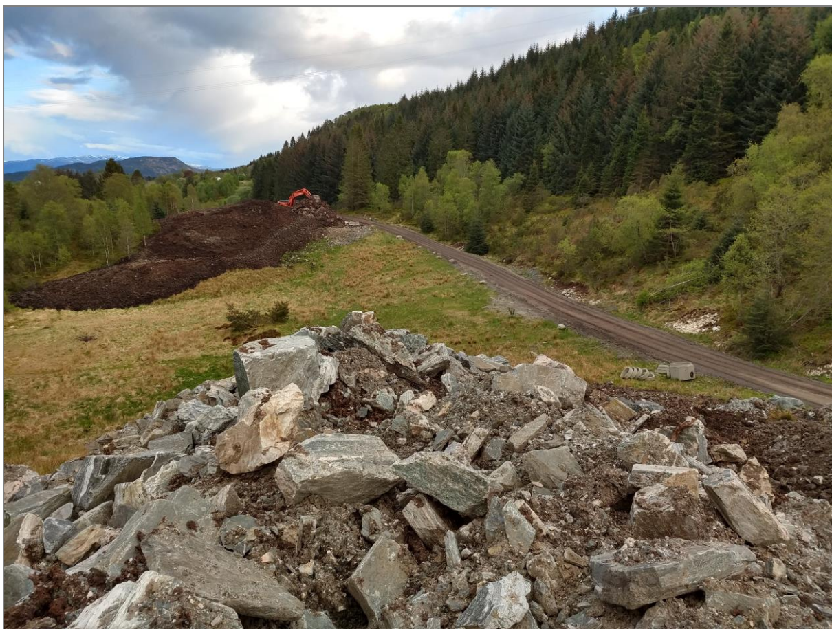
Figur 7. Ferdig skogsbilvei på Hylkje (del av Hordvik – Hylkje). Et «fjell» av overskuddsmasser er her dumpet utover beitemark. Massene ligger der fortsatt, men er nå overgrodde. Bildet er tatt fra toppen av det ene «fjellet». Byggingen av skogsbilveien er under etterforskning av Vest politidistrikt. Foto: Synnøve Spangelo.
