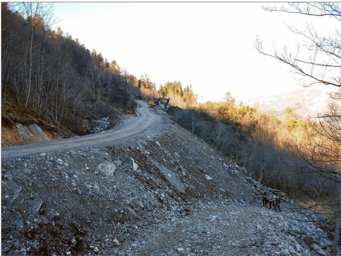
Figur 3. Skogsbilvei på Brattland under bygging. Bilde tatt våren 2023. For målestokk på fylling, se menneskene nede til høyre i bildet. Foto: Synnøve Spangelo.
