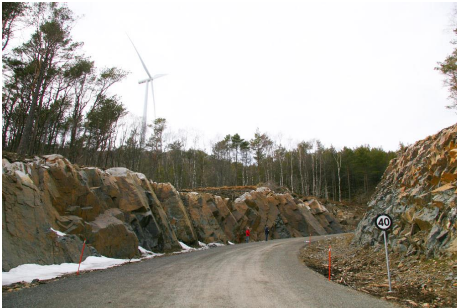
20 – 25 m bred skjæring i kurve – fra Lista – merk dimensjoner i forhold til personen Foto: Sveinulf Vågene
