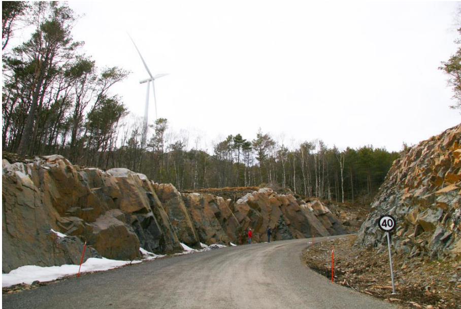
20 – 25 m bred skjæring i kurve – fra Lista – merk dimensjoner i forhold til personen Foto: Sveinulf Vågene
